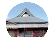
茅葺き屋根改修
